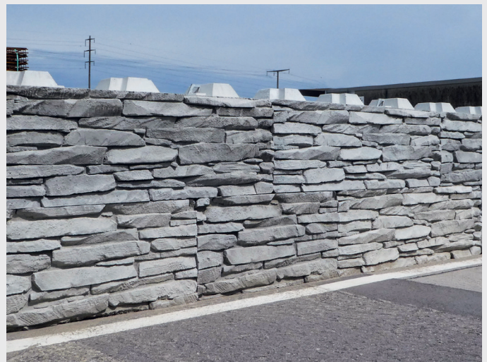
Mauerwerkstruktur in Schieferoptik – Brabant
